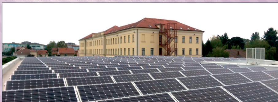
IZGRADNJA SUNČANE ELEKTRANE NA STUDENSKOM RESTORANU U VARAŽDINU
