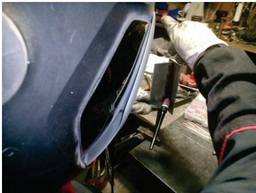
Slika 4. Prikaz vertikalnog zavarivanja T - spoja prema gore
