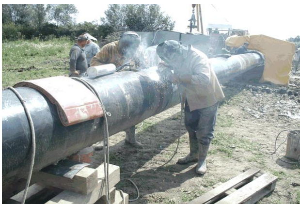
Slika 5. REL zavarivanje cjevovoda celuloznom elektrodom (silazna tehnika)
