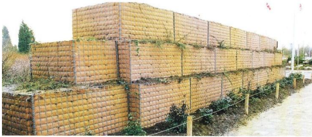
Slika 4. Gabionski zid za zaštitu od buke
