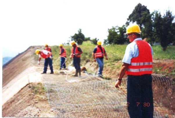
Slika 2. Postavljanje žičanih mreža na bioplatno
