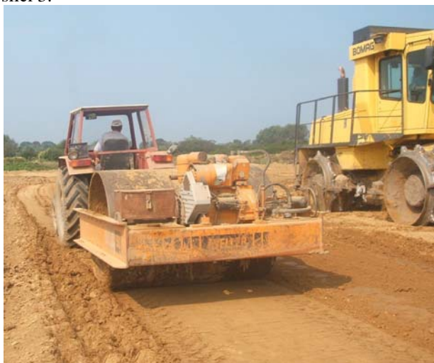
Slika 3. Prijelaz valjka preko zemljane ispunje
