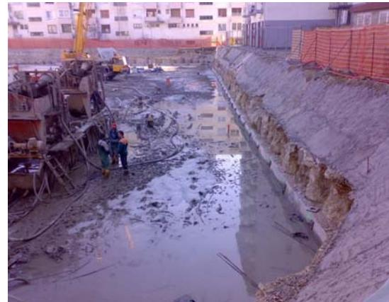
Slika 4. Prikaz dijela vertikalnih stupnjaka
