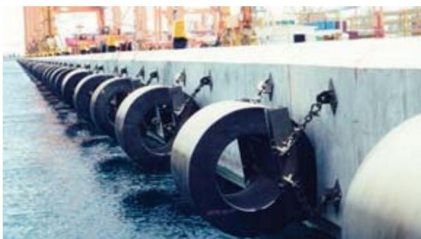
Slika 2. Primjer primjene elastičnog šupljeg gumenog odbojnika
