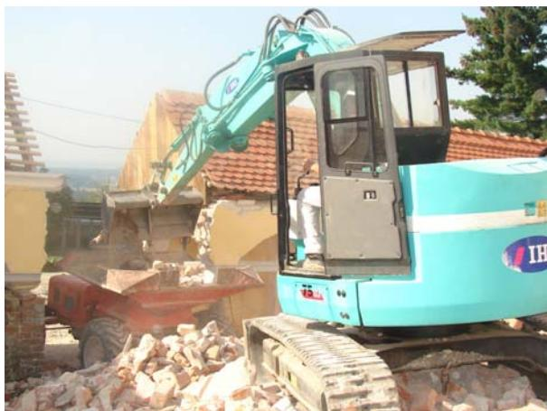
Slika 12. Mali bager i demper na odvozu urušenog materijala (oko 1000 m<sup>3</sup>) na privremeni deponij
