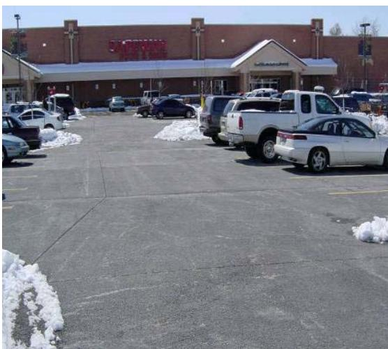
Slika 2. Propusni betonski kolnik
