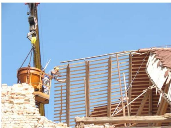
Slika 11. Rušenje oštećenih nevezanih dijelova iz sigurnosnih razloga
