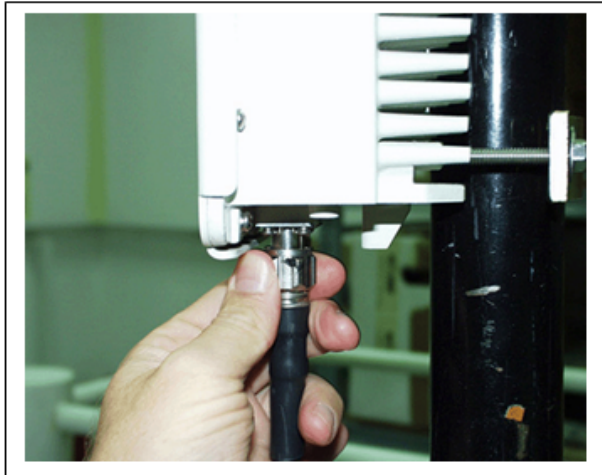
Slika 8. Spajanje koaksijalnog kabla na sektorsku antenu
