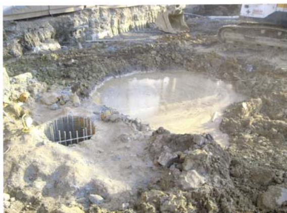
Slika 8. Izvedeni CFA piloti u tlu
