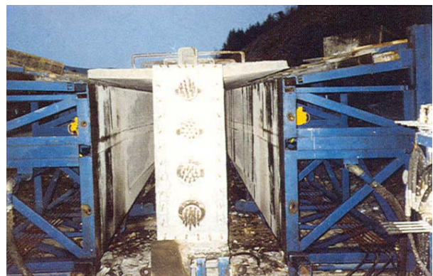
Slika 6. Izbetonirani nosač u kalupu
