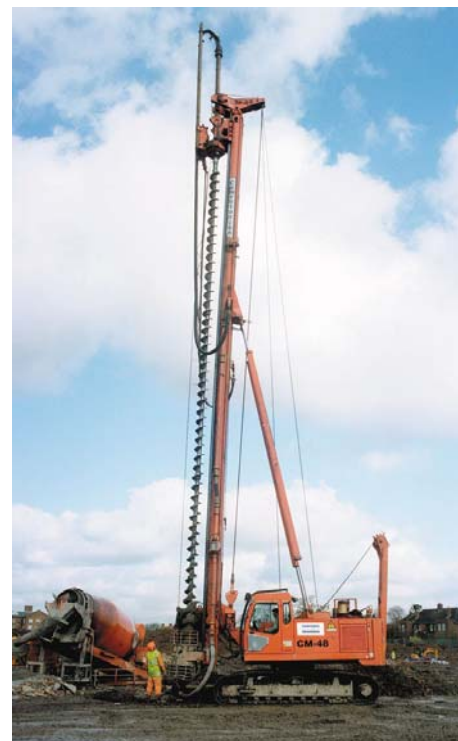
Slika 1. Bušeća garnitura za CFA pilote
