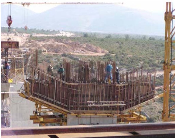
Slika 5. Izvedena skela i oplata naglavnice
