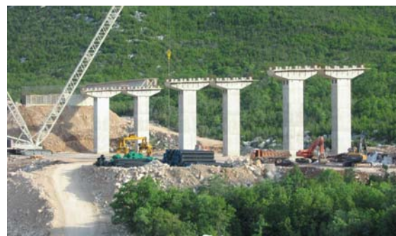
Slika 1. Montaža stupova i upornjaka
