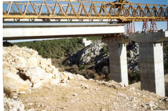
Slika 8. Montiranje glavnog nosača navlačnom skelom
