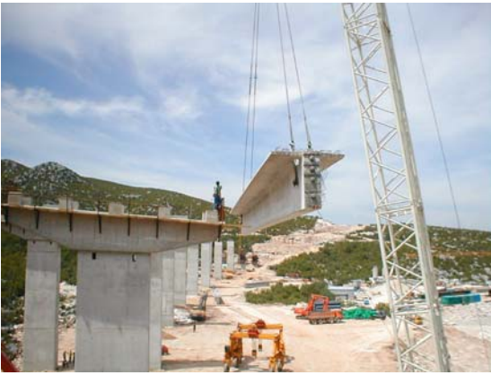
Slika 7. Montiranje glavnog nosača auto dizalicom
