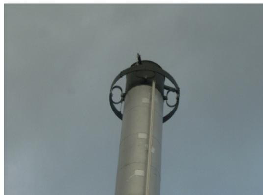
Slika 7. Prigušenje dimnjaka pomoću opruga
