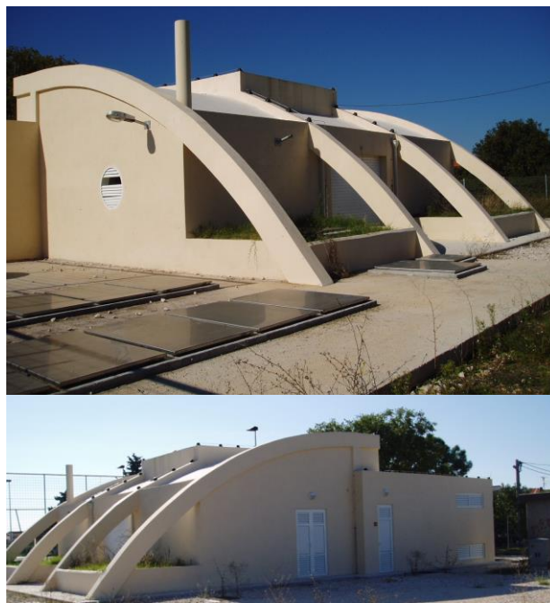
Slika 2. Crpna stanica Arbanasi - Zadar
